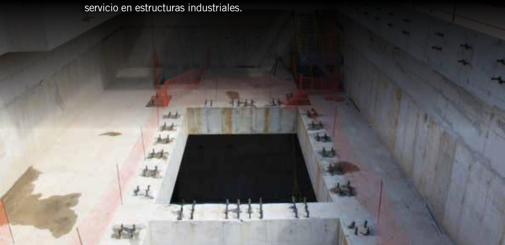
Los productos Xypex asumen un rol clave en la impermeabilización y protección del concreto contra la penetración de agua por presiones hidrostáticas, y agresivos ataques químicos – problemas típicos asociados con la reducción del tiempo de vida útil de estructuras industriales de concreto.
